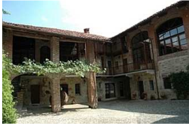
Ristrutturazione centro storico
